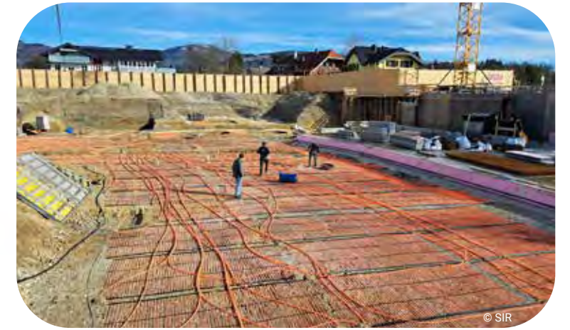
Verlegung der Erdkollektoren zur Nutzung der Erdwärme
