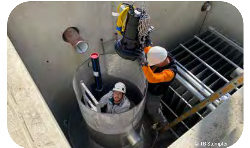
Montage des Wärmetauschers im Abwasserschacht
