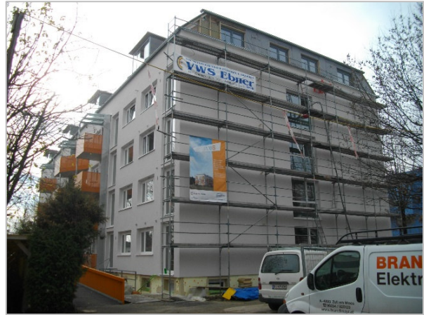
WÄHREND des Umbaus – Sanierung & Aufstockung. © SIR
