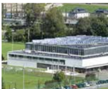
Handlungsfeld 2 – Kommunale Gebäude und Infrastruktureinrichtungen
