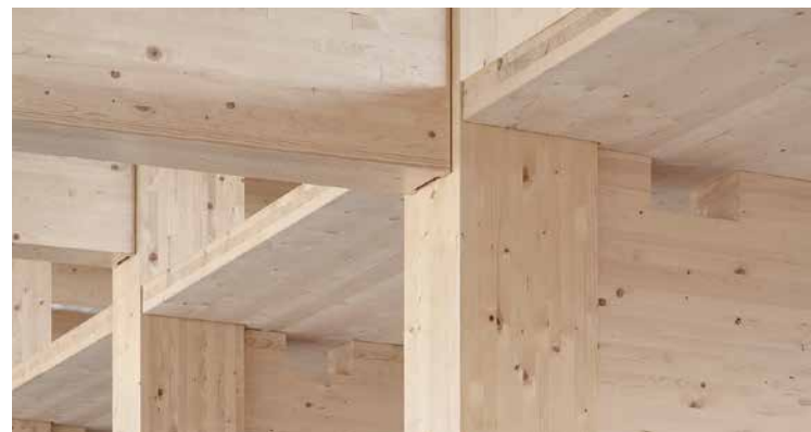
Gesteckte Verbindungen der Holzelemente
