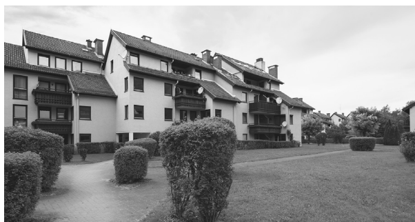
Blick in den Innenhof – vorher (2016), © Christof Reich
