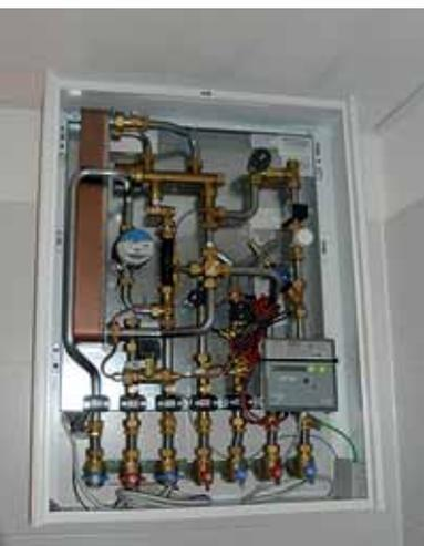
In jeder Wohnung befindet sich eine Übergabestation. Hier wird die benötigte Wärme gezählt und das häusliche Warmwasser dezentral erzeugt. Vorteile: Geringe Verluste und hygienisch einwandfrei.
