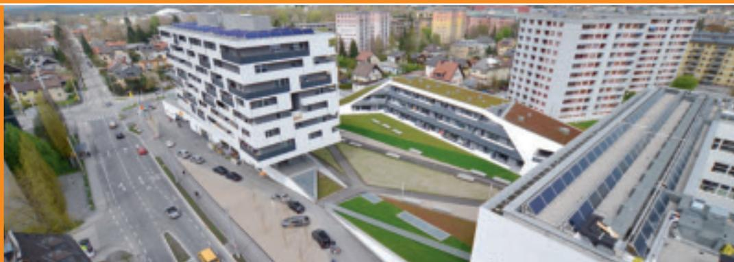
Auf den Dächern sind Solaranlagen situiert, diese liefern Wärme für Warmwasser und Heizung.
