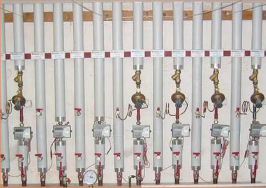
Alle Leitungen werden bis zum letzten Ventil gedämmt um Wärmeverluste zu vermeiden.
