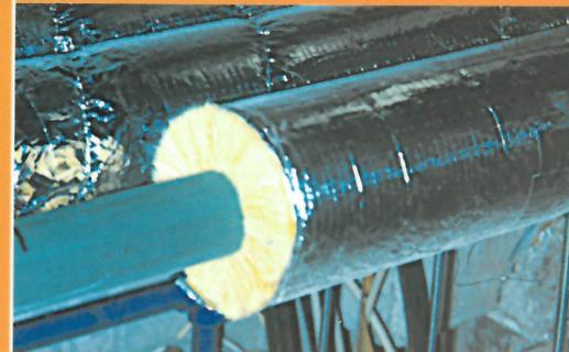
Gute Isolierung vermindert die Wärmeverluste in den Leitungen.
