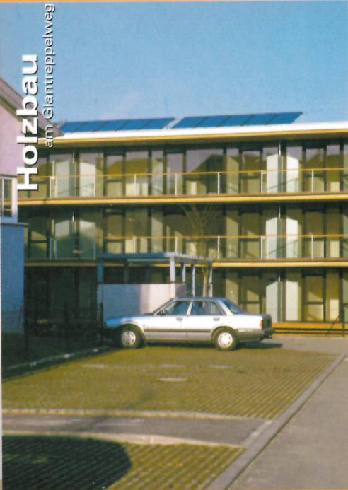
Die Solaranlage am Dach dient zur Warmwasserbereitung im Sommer und in der Übergangszeit.
