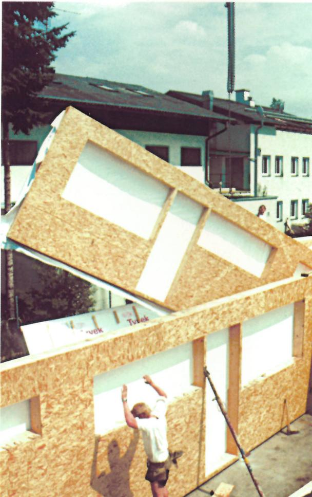
Bei einer weiteren Standardisierung der Bauweise sind noch Einsparpotentiale durch verstärkte Vorfertigungen und auch weitere Verkürzungen der Bauzeit möglich.
