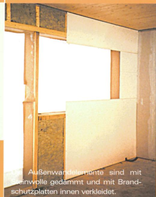
Die Außenwandelemente sind mit Steinwolle gedämmt und mit Brandschutzplatten innen verkleidet.
