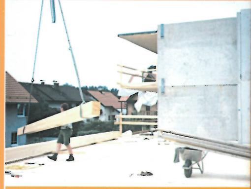
Die vorgefertigten Deckenelemente werden angeliefert und versetzt.
